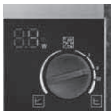
3-Stufen-Funktion bei der Wilo-Yonos PICO.
